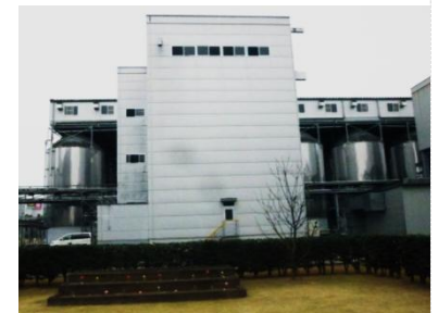
〔33万リットルの仕込みタンク〕
